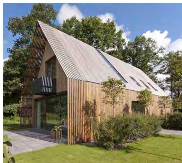
Materiaal gevels passend bij een woonwijk in het groen
