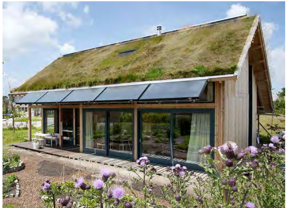
Zonnepanelen weggewerkt in 'groen' dakvlak
